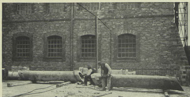
BEHAUEN UND BOHREN MITTELS PRESSLUFT
