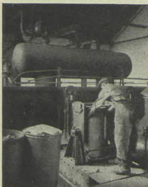
STAUBFREIE FÜLLVORRICHTUNG DER MÜLLVERBRENNUNGSANLAGE IN DAVOS.
